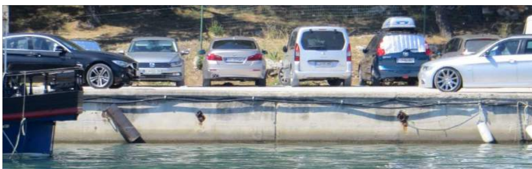
Fotografija 19: Betonska riva u nautičkoj luci
