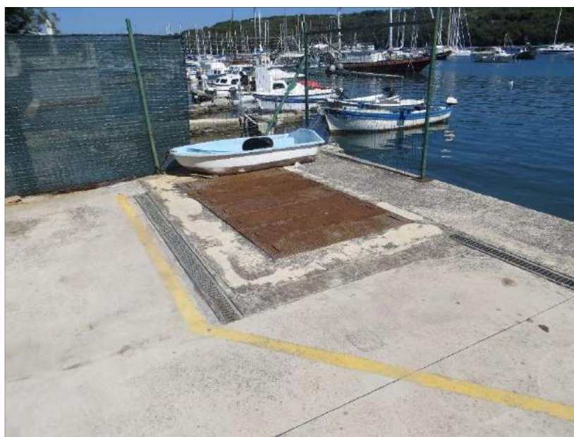
Fotografija 15: Nautička luka Bunarina (postojeća slivna rešetka koja ih vodi do separatora ulja i masti na samom kraju obalnog platoa)
